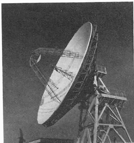
Fig. 5 - Terminale a terra di satellite sperimentale, di diametro 14 metri (45 piedi) della Plessey installato a Cowes, Isola di Wight, stabilimento della Plessey Radar.
